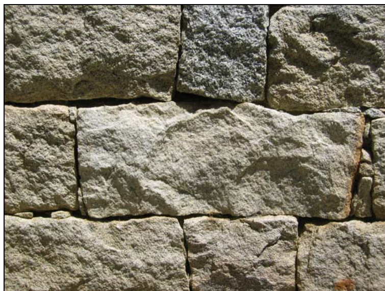
Mur en pierres sèches.
