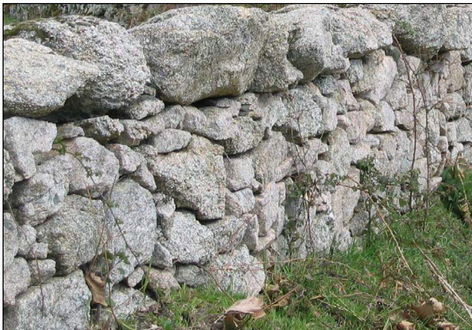
Détail de muret en pierres sèches
